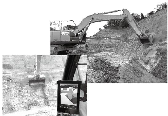
ICT重機を用いた掘削の様子
